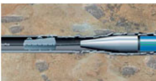
Разрушение ветхих труб с одновременной заменой
